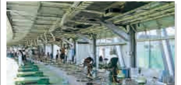
ゴルフ練習場での冷房に 天吊り・据置き兼用タイプ(薄型)
