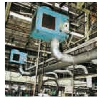
機械工場加工ラインの冷房に天吊り・据置き兼用タイプ(防雨型)
