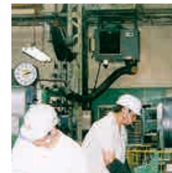
プレス加工工場の冷房に天吊り・据置き兼用タイプ
